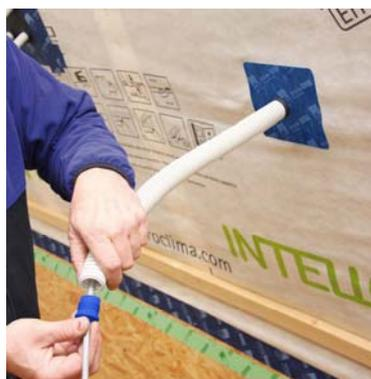
**Figure 9 : Mise en place du bouchon STOPPA**
