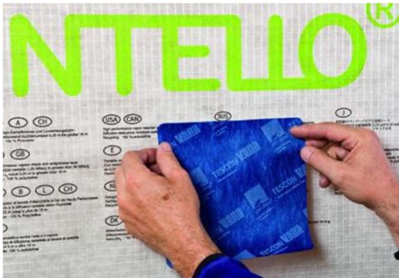
Figure 12 : colmatage des endommagements avec pro clima TESCON VANA Patch ou TESCON VANA 200 mm
