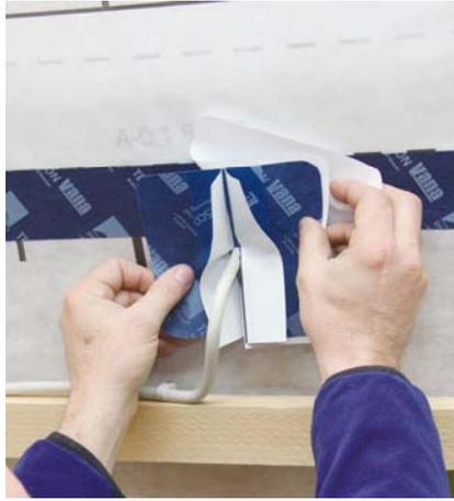
**Figure 7 : Mise en œuvre de la manchette Kaflex Post**
