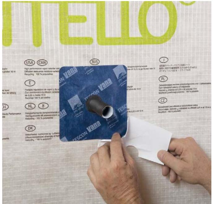
**Figure 34 : Mise en place de la manchette ROFLEX 20**
